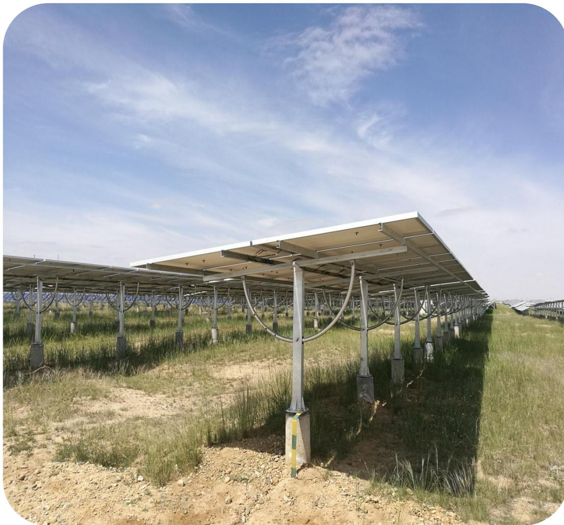
四季可调支架：固定可调支架随着季节的变化太阳高度角发生变化，调整支架俯仰角，使太阳光线尽量垂直照射太阳能阵列，调节度数为 $6^{\circ}$ 、 $30^{\circ}$ 、 $41^{\circ}$ 、 $58^{\circ}$ ；
