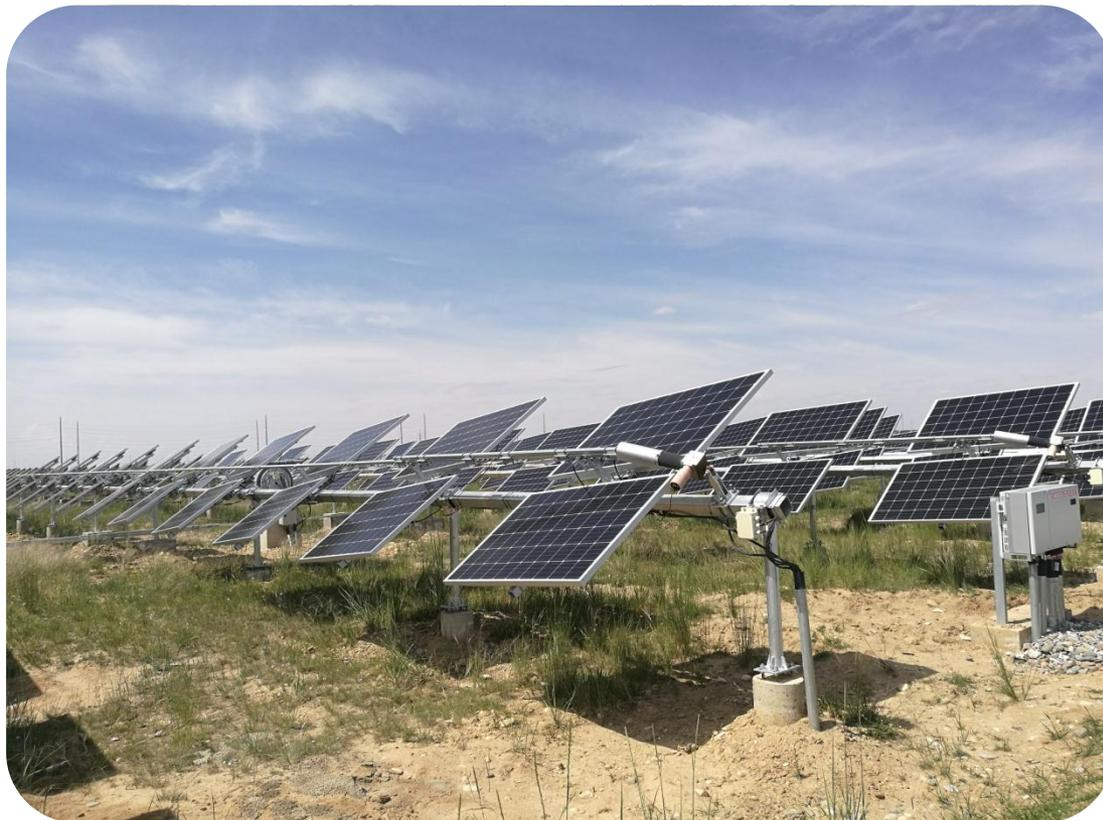
**鳞片式双轴：**鳞片式双轴跟踪系统基于天文计算法原理工作，通过六轴陀螺系统测量电池板实际姿态构成闭环控制系统，具有反阴影跟踪和集中管理的控制功能。跟踪系统在东西联动平单轴系统的基础上对电池板的南北倾角进行自动调整，构成了平面型的双轴跟踪系统。该系统具有双轴系统的发电量提升率，但与传统双轴系统相比具有抗风能力强和易于清洁维护的。
