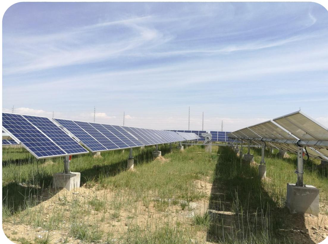
平单轴支架：斜单轴跟踪系统根据天文算法结合当地的经纬度得出太阳的方位角，然后反馈到跟踪平面上，结合**GPS**时间，计算出太阳和组件的最佳角度，通过集成控制器控制传动电机进行角度调整，从而达到光伏组件与太阳辐射的最佳角度。
