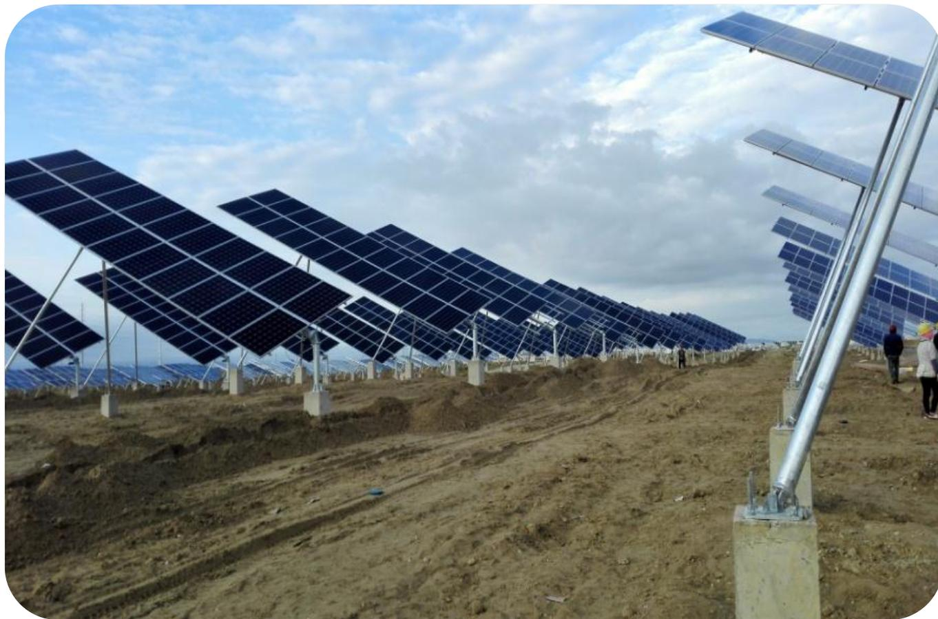
斜单轴支架：根据天文算法结合当地的经纬度得出太阳的方位角，然后反馈到跟踪平面上，结合GPS时间，计算出太阳和组件的最佳角度，通过集成控制器控制传动电机进行角度调整，从而达到光伏组件与太阳辐射的最佳角度，斜单轴采用中信博AT.C.H.24.NL型号控制箱以及传动机构采用型号为HB-DJ818进行驱动支架调整，从而达到光伏组件与太阳辐射的最佳角度，支架跟踪范围为 $\pm 45^\circ$ ，跟踪精度为 $2^\circ$ 。
