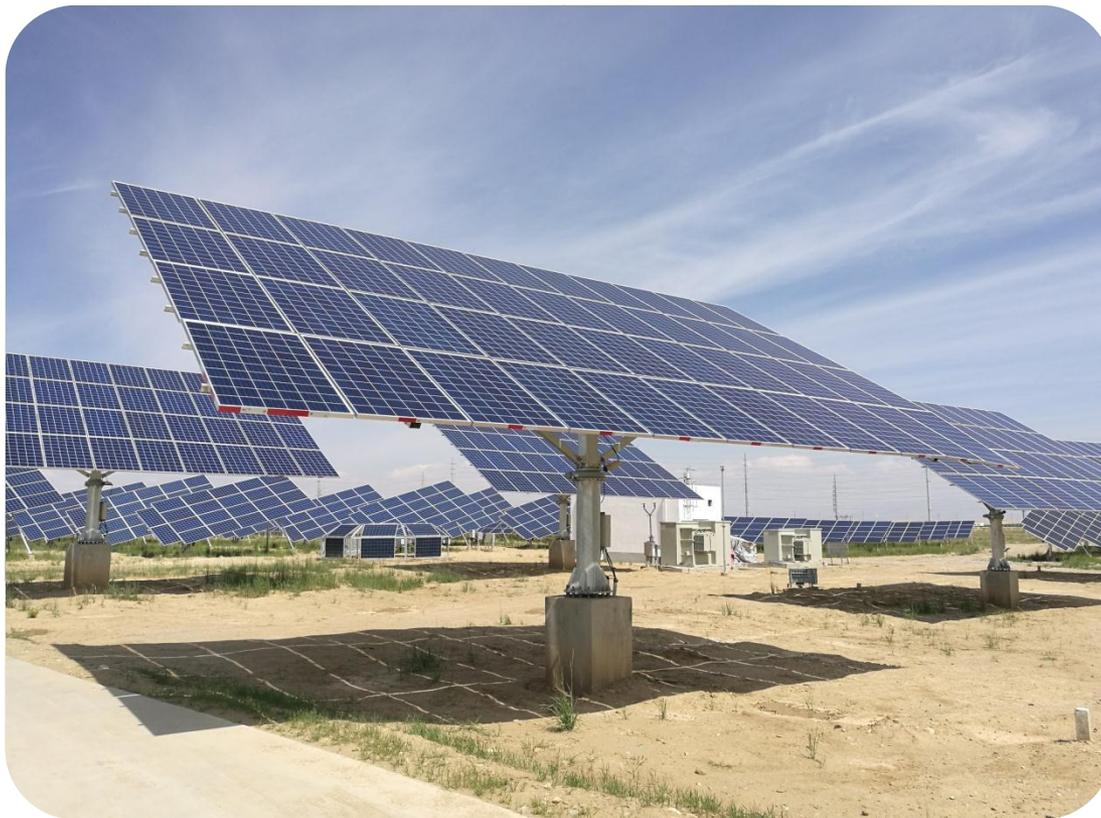
双轴支架：双轴跟踪系统根据天文算法结合当地经纬度得出太阳的方位角，然后反馈的跟踪平面，结合GPS时间计算出组件的最佳倾角；通过PLC控制传动电机进行角度调整，从而达到光伏组件与太阳照射的最佳角度。双轴采用睿基solartrackerRev1.2追日控制系统，具备夜间自返、抵御自然灾害、故障自检等功能；驱动系统采用型号为SE-9减速机系统，具备自锁功能；在俯仰转动方向上采用“四连杆”结构，整个网架五点支撑，网架抖动幅度小，俯仰转动 $15^{\circ} \sim +90^{\circ}$ ，水平转动范围 $\pm 120$ 度。
